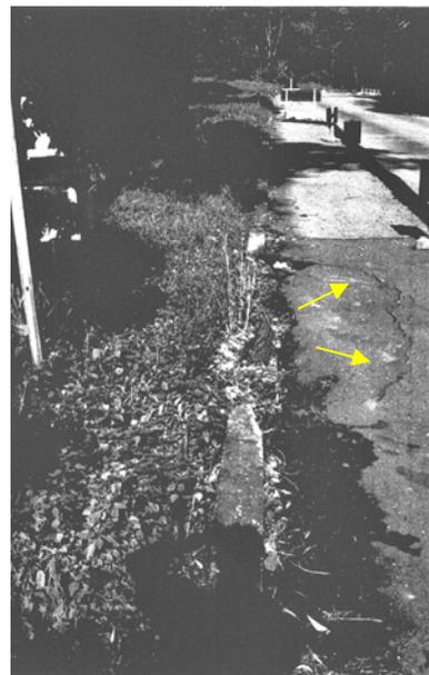
Figuras A3.25 e – A3.26 Oc 48: Km 96,220 – Ruptura parcial do aterro ocasionando trincas, abatimentos e interdição do acostamento.
