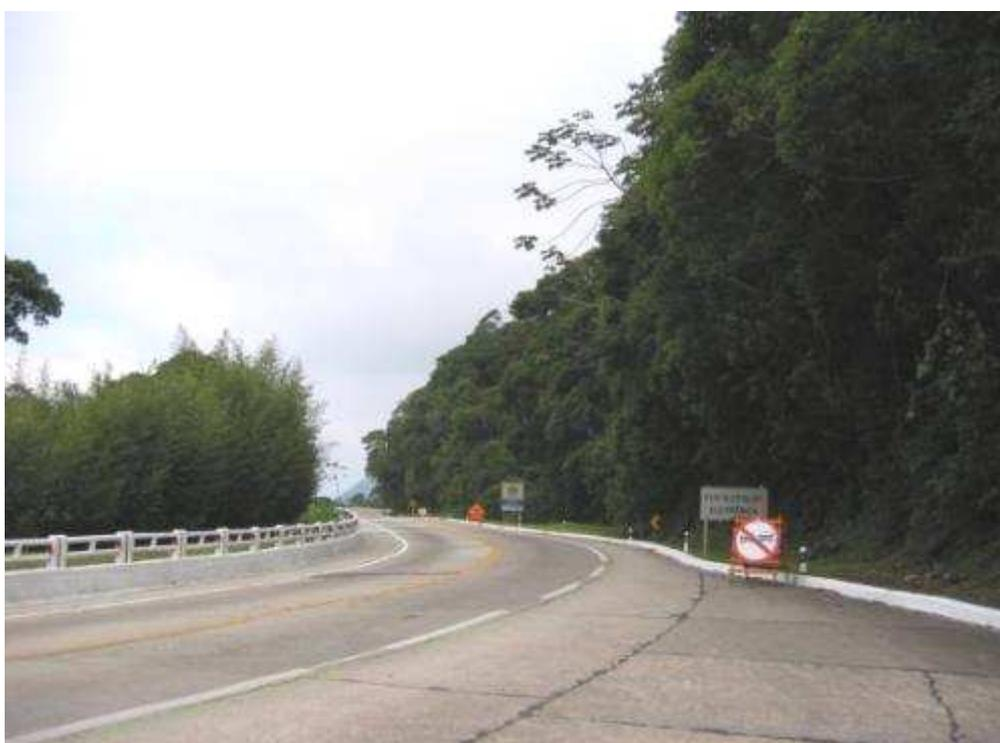
Figura A1.12 - Km 91,200 – Presença de depósito de tálus/colúvio ao longo dos cortes da estrada. Neste trecho as declividades dos taludes de montante são muito acentuadas. Foto sentido Teresópolis.
