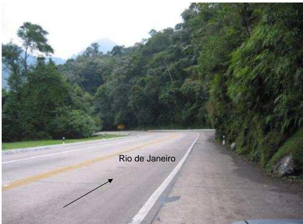
Figura A1.23 - Km 96,100 – Trecho caracterizado pela presença de um talude misto (corte com afloramento rochoso na base e de solo nas porções superior e média) com possibilidade de ocorrência de escorregamentos planares, caracterizando uma situação similar àquela existente no Km 95. Foto sentido Rio.
