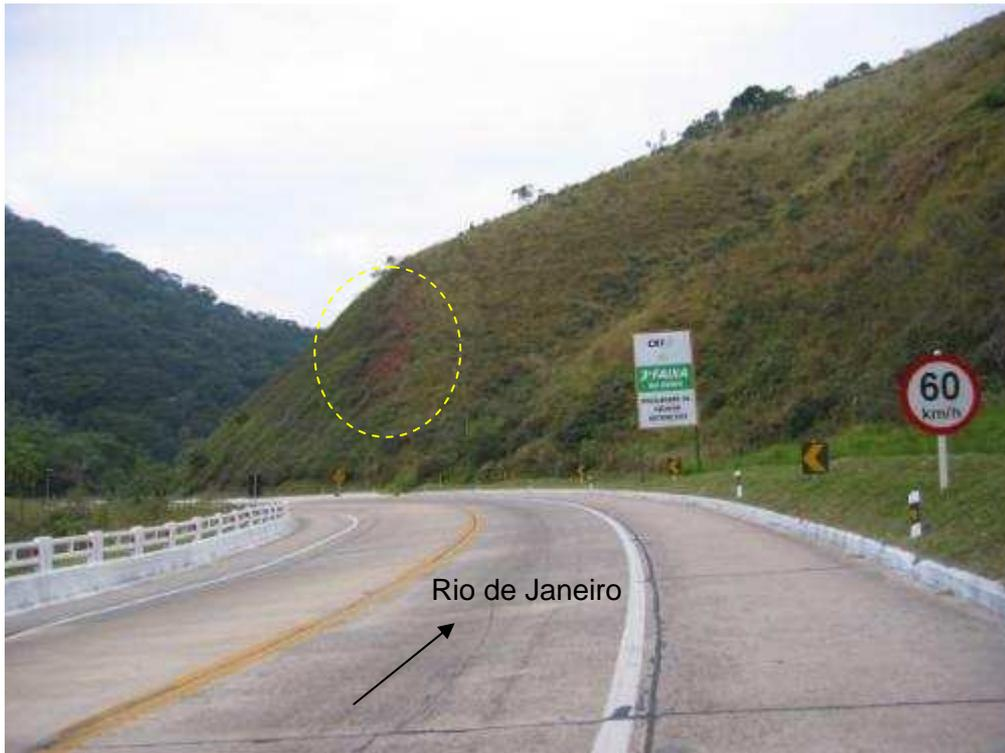
Figura A1.29 - Km 100 – Início do desenvolvimento de processos erosivos (oval amarelo tracejado) e diminuição progressiva do espaço livre entre o pé do talude e a pista, conseqüentemente aumentando o risco geológico.
