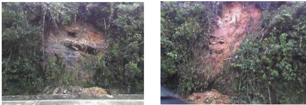
Figuras A3.48 e A3.49 – Vistas de deslizamentos translacionais de pequeno porte, envolvendo capa de solo superficial (provável colúvio sobre solo residual) assente diretamente sobre maciço rochoso pouco alterado. Os movimentos ocorreram nos Km 90,400 e 90,480 em algum momento entre os dias 21 e 22 de janeiro de 2009. As fotografias foram obtidas no dia 25 de janeiro de 2009.
