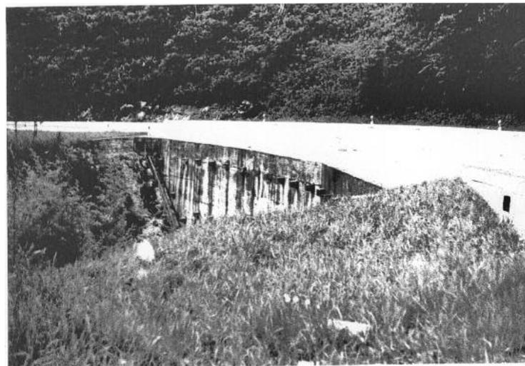
Figuras A3.23 e A3.24 Oc 45: Km 96,050 – Intenso processo erosivo levando a destruição da saia de aterro sob a pista e conseqüente destruição parcial do acostamento, deixando placas de concreto em situação de balanço. A Figura A3.24 Mostra a obra de contenção executada e reconstrução integral do trecho da pista afetado.
