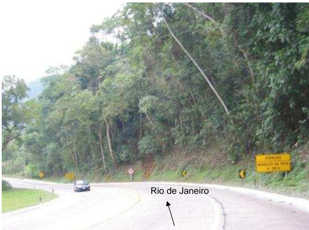
Figura A1.30 - Km 100,700 – Ocorrência de depósitos de tálus/colúvio em talude escavado ao longo da pista. A partir desse quilômetro, observa-se o aumento da densidade populacional da estrada, com condomínios de casas próximos às pistas de rolamento.
