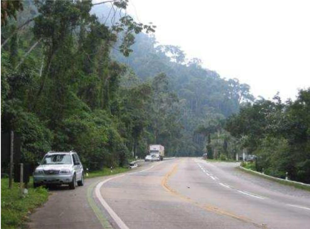
Figura A1.9 - Km 90,300 – Próximo ao restaurante Paraíso das Plantas. Ocorrência de depósito de tálus / colúvio recobrimdo o trecho de encosta a montante e a jusante da pista. Em alguns segmentos no final do Km 90, existem fossos entre o pé do talude e a pista suficientes para evitar que escorregamentos de pequeno porte atinjam a pista.
