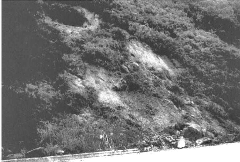
Figura A3.40 – Oc 59: Km 101,000 - Escorregamento translacional raso atingindo o acostamento da pista.
