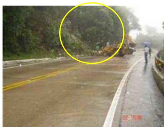
Figuras A3.51 E A3.52 – Vista de deslizamento translacional (Oc 99), ocorrido em 22/1/2009 às 07h22min envolvendo capa de solo superficial, nas imediações do Km 93,800. O material de descida interrompendo parcialmente o tráfego. A fotografia (cedida pela CRT) foi obtida no dia 22 de janeiro de 2009, por volta das 10h30min da manhã, quando eram iniciados os trabalhos de remoção do material.
