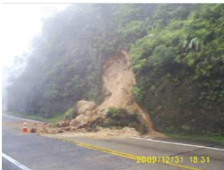
Figura A3.56 – Foto da Oc. 104, o material escorregado atingiu o acostamento e uma das faixas de rolamento.
