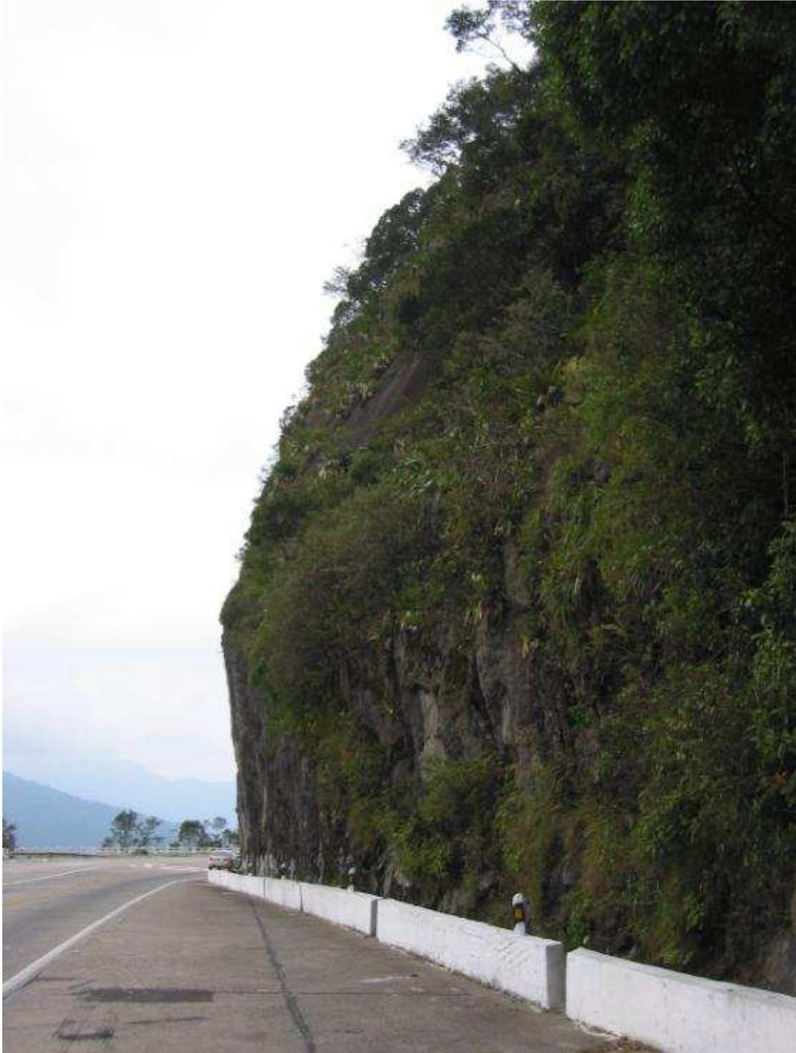
Figura A1.14 - Km 92,300 – Corte rochoso ao longo do KM 92. Neste trecho, existem segmentos onde o afastamento do pé do talude em relação à pista é quase inexistente, potencializando significativamente o risco em relação a desprendimentos seguidos de quedas de lascas e fragmentos rochosos.
