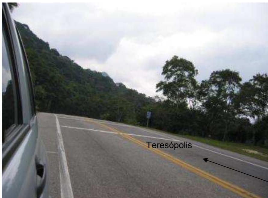
Figura A1.31 - Km 101 – Trecho com lenta e intermitente movimentação de depósito coluvionar atravessado pela pista de rolamento, que sofre as consequências da movimentação apresentando recalques e fissuras. O trecho é objeto de pesquisa pela COPPE e conta com instrumentação geotécnica. A partir de meados do ano de 2010, como o início da construção da 3ª pista, este trecho foi palco de fortes intervenções, com nivelamento, recapeamento e drenagem, visando sua estabilização.
