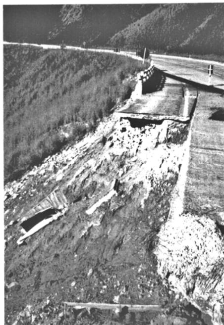
Figuras A3.38 e A3.39 – Oc 58: Km 100,000 - Escorregamento da saia do aterro que inutilizou parte da plataforma rodoviária com a destruição de inúmeras placas de concreto.
