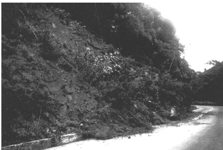
Figura A3.33– Oc 55: Km 99,200 - Escorregamento da translacional atingindo a pista.
