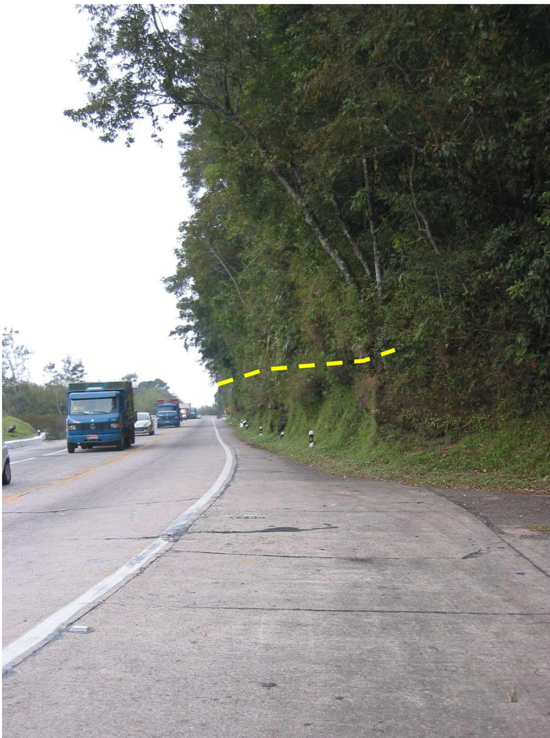
Figura A1.15 - Km 92,600 – Corte de perfil misto rocha ( afloramento na parte inferior do talude) e solo (residual sob colúvio, nas partes média e superior do talude).
