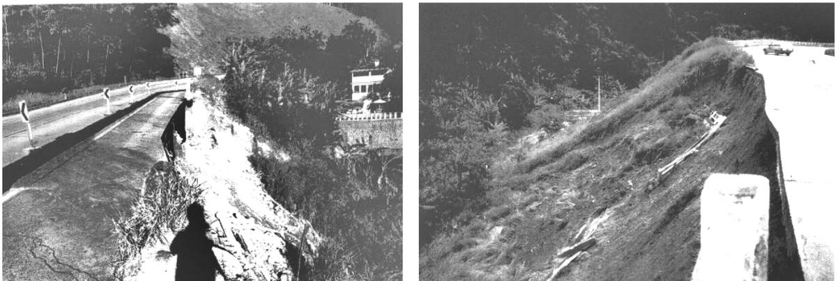
Figuras A3.36 e – A3.37 Oc 58: Km 100,000 - Escorregamento da saia do aterro, comprometendo a estabilidade do acostamento.
