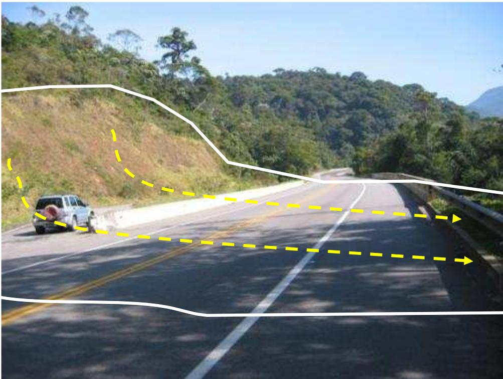
Figura A1.2 - km 87 – Local de ocorrência de um grande acidente (linha tracejada) (Ev. 13 Oc. 77 08/02/2005). Ali foi instalada uma instrumentação geotécnica (piezômetros e inclinômetros) e construído um sistema de drenagem sob e a jusante da pista. O maciço rochoso aflora a montante do acostamento.
