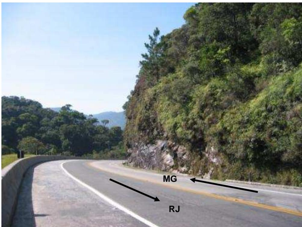
Figura A1.4- Km 88 (parte inicial) – Ocorrências de taludes rochosos verticais, escavados para a implantação da via e cujas bases se encontram muito próximas da pista. Foto sentido Além Paraíba (MG).
