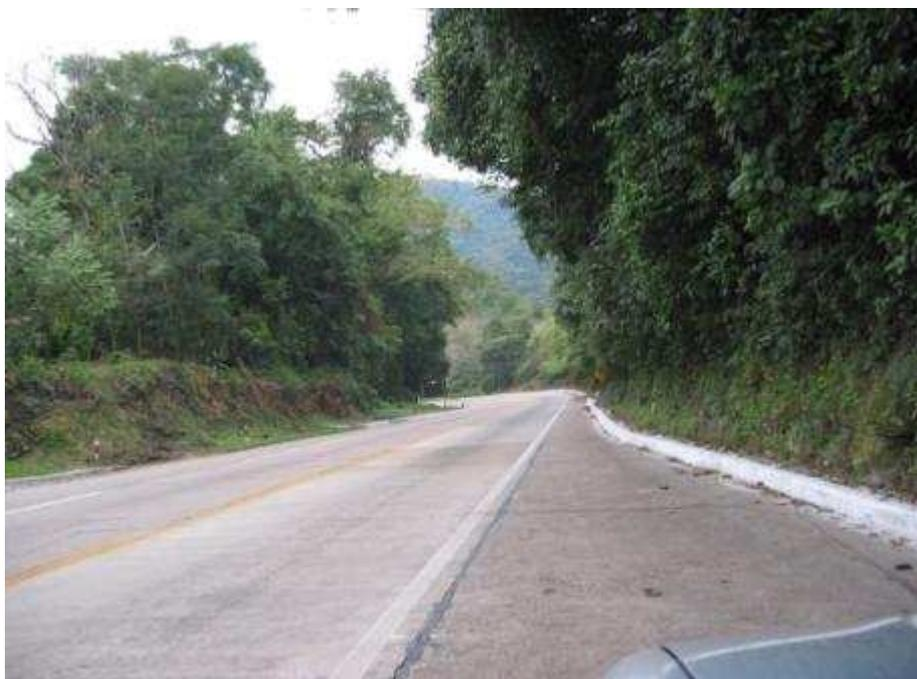
Figura A1.34 – Segmento do Km 102 com presença de depósito de coluvionar nos taludes ao longo da pista e baixo risco potencial (pequena freqüência de ocorrências). A partir deste trecho da Rodovia em direção ao Rio de Janeiro, começa a ser mais intensa a presença de moradias e comércio. Já no quilômetro 103, observa-se alta densidade populacional e praticamente inexistência de taludes.
