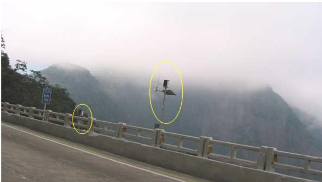
Figura 4.6 – Estação Automática da CRT, BR 116 KM 90 (próximo ao Alto do Soberbo). Neste local, desde existem duas estações em funcionamento, sendo que uma transmite por satélite e outra por fibra ótica.
