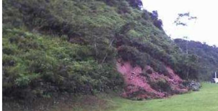
Figura A3.50 – Vista de deslizamento translacional, envolvendo capa de solo superficial (provável colúvio sobre solo residual) assente diretamente sobre maciço rochoso pouco alterado. O movimento ocorreu no Km 95,650 em algum momento entre os dias 21 e 22 de janeiro de 2009. A fotografia foi obtida no dia 25 de janeiro de 2009.
