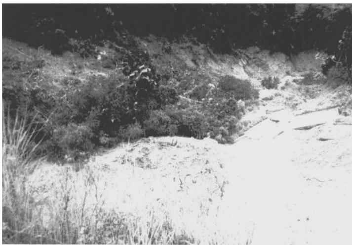
Figura A3.30 – Oc 52: Km 98,900 – Escorregamento com crista em talude a montante da pista, porém com sérias conseqüências ao sistema de drenagem e ao talude de jusante.
