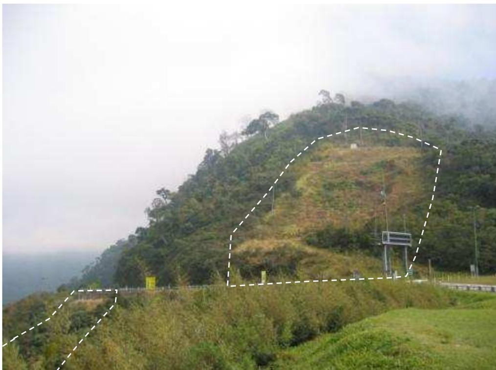
Figura A1.7 - Km 89,500 – Região do Alto do Soberbo (final da subida da Serra). Presença de obras de contenção e de escorregamentos a montante e a jusante da pista. Entre os cem metros finais do Km 89 e os duzentos iniciais do Km 90, existe um paredão rochoso a montante da pista com alta suscetibilidade escorregamentos.
