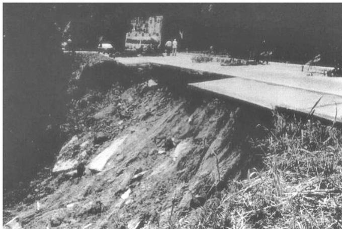
Figura A3.12 Oc 40: Km 91,800 – Ruptura da saia do aterro ocasionando destruição parcial da pista de rolamento.
