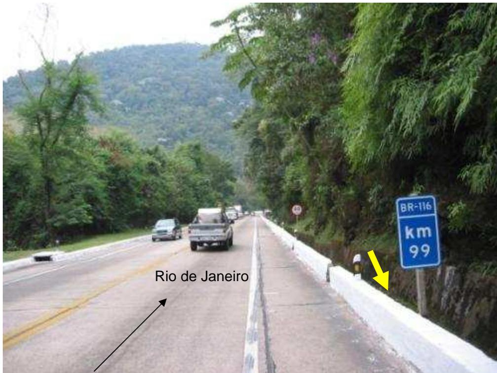
Figura A1.27 - Km 99 – Presença de fosso (seta amarela) ao longo da pista mitigando, significativamente, o risco de atingimento da pista por blocos rochosos e pequenos escorregamentos terrosos deflagrados no talude de montante.
