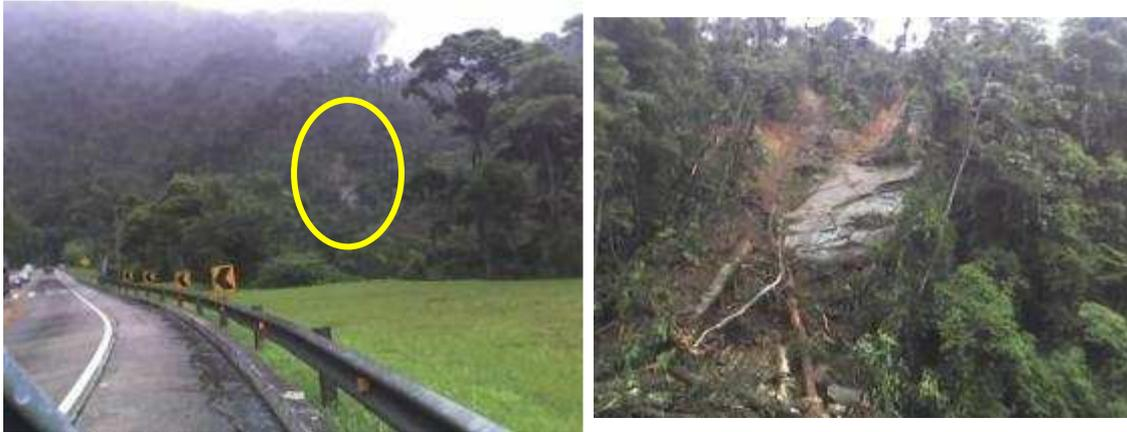
Figuras A3.46 e A3.47 – Vista geral e detalhe de deslizamento translacional de solo superficial assente diretamente sobre maciço rochoso pouco alterado, ocorrido no Km 91,050, no dia 21 de janeiro de 2009, às 19h26min (Oc 95). As fotografias foram obtidas no dia 25 de janeiro de 2009.
