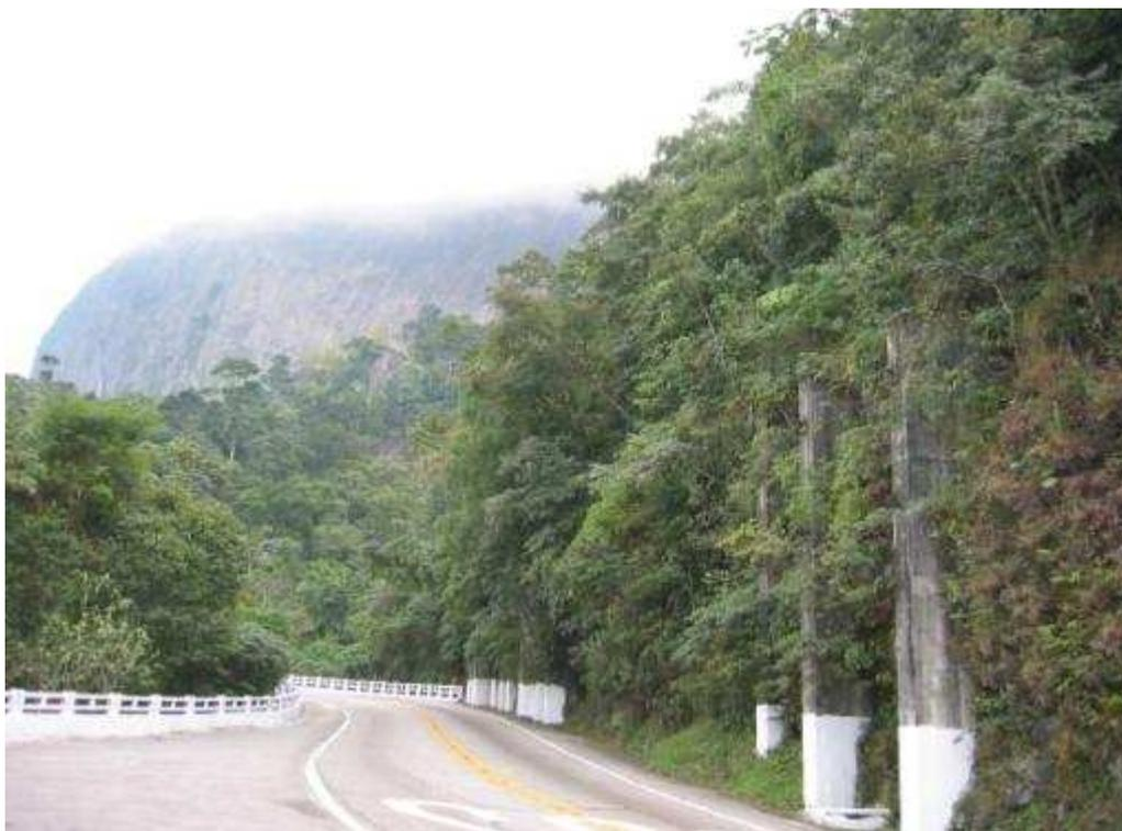
Figura A1.16 - Km 93,500—Corte, em rocha, recoberto por vegetação, com possibilidade de queda de blocos e com algumas intervenções (contrafortes ancorados) para mitigação do risco. Trecho próximo da Curva do Garrafão, onde a pista é muito sinuosa.
