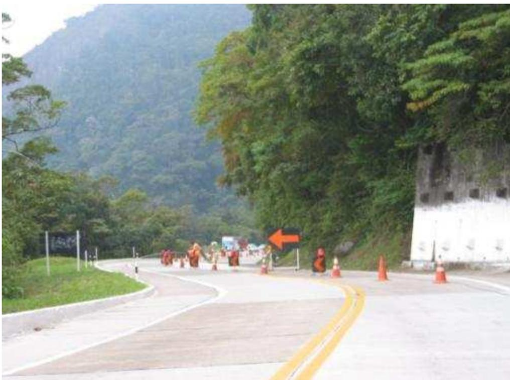
Figura A1.13 - Km 91,600 – Obra de contenção (cortina ancorada) estabilizando talude escavado em depósito de tálus/colúvio que se movimentou na década de 1980. Nos últimos 200 metros desse quilômetro, observaram-se trechos de afloramento de lascas rochosas, com possibilidade de escorregamentos planares sobre a rocha.
