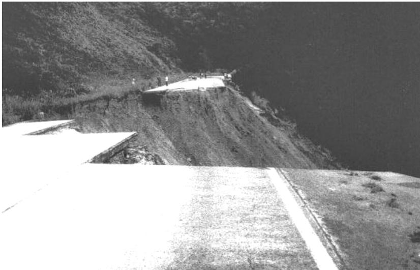
Figuras A3.27 e – A3.28 Oc 51: Km 98,700 – Ruptura total do aterro ocasionando a interrupção do acesso a Teresópolis por vários dias.
