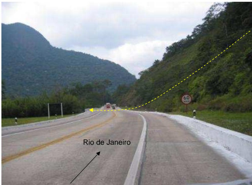
Figura A1.26 - Km 98,300 – Trecho de 200m com intercalações de segmentos apresentando variadas larguras de faixas de afastamento entre o pé do talude e a pista. Os Eventos Pluviométricos Ev.4 (02/12/1981) e Ev.7 (17-18/01/1991) provocaram importantes acidentes geológicos (linha tracejada) os Km 98 e 99, sendo a trajetória de um deles indicada pela linha amarela tracejada.
